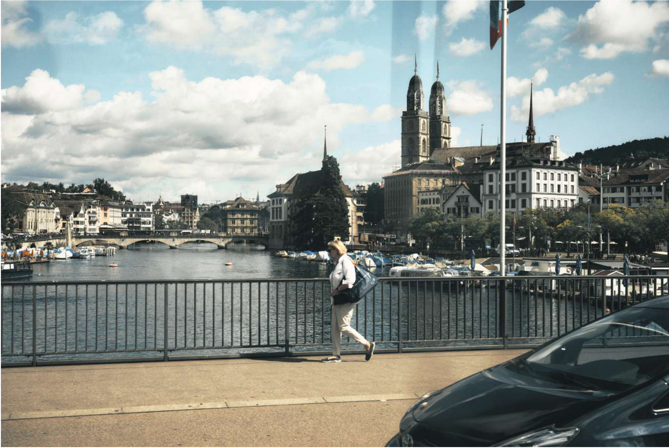
Die Quai­brücke ver­schiebt sich pro Jahr um einen Milli­meter. Der Grund für die Wan­derschaft der Brücke liegt im Baugrund aus weicher, nachgiebi­ger Seekreide.
